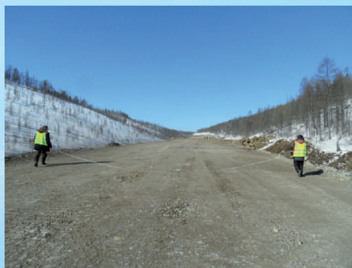
Строительный контроль на автодороге М 56 "Лена" км 444 - км 455
