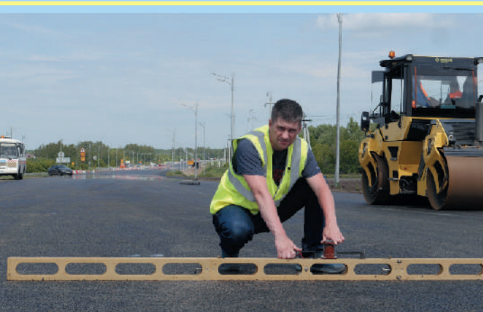
Строительный контроль на автодороге подъезд к аэропорту Казань
