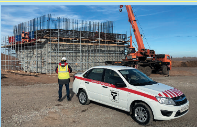
Строительный контроль на скоростной автомагистрали М-12
