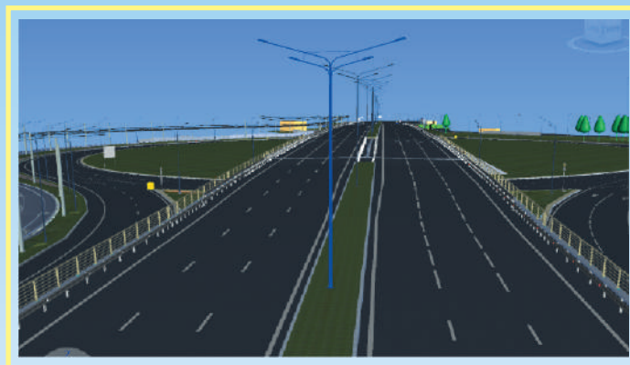
Транспортная развязка на км 1052+600 автодороги М 7 Волга запроектированная с помощью BIM технологий
