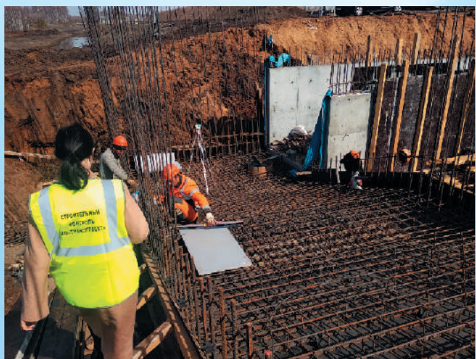
Строительный контроль на автодороге подъезд к аэропорту Казань
