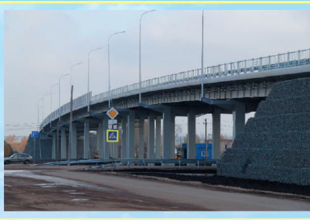
Путепровод с подходами через железную дорогу Алнаши-Бугульма в г. Заинск
