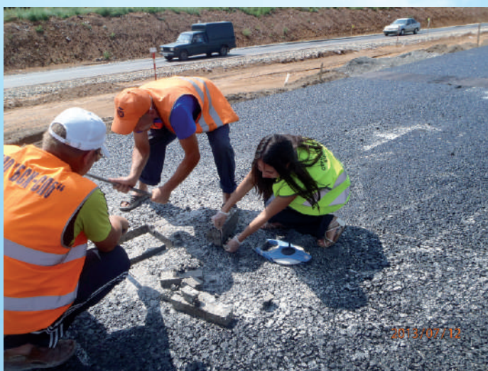
Строительный контроль на автодороге М 7 "Волга" км 941 - км 957
