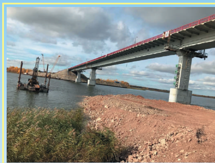
Бурение скважин под опоры моста через реку Свияга с понтона
