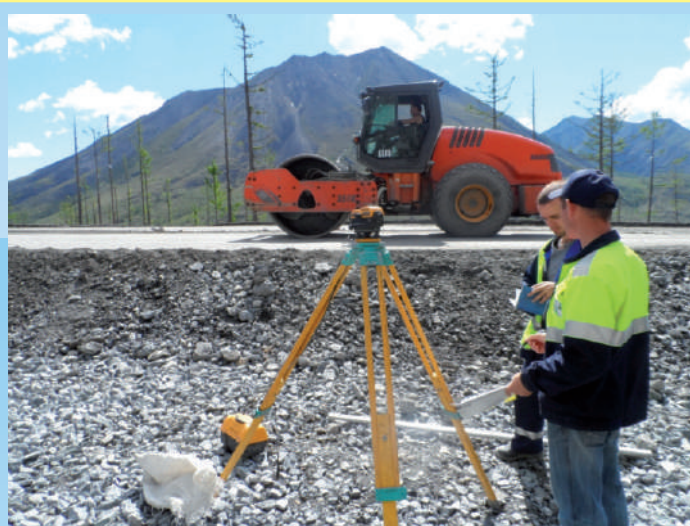
Строительный контроль на автодороге «Колыма» км 603 – км 632
