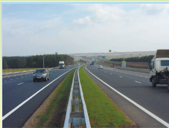
Реконструкция автодороги М 7 « Волга» км 978- км 989
