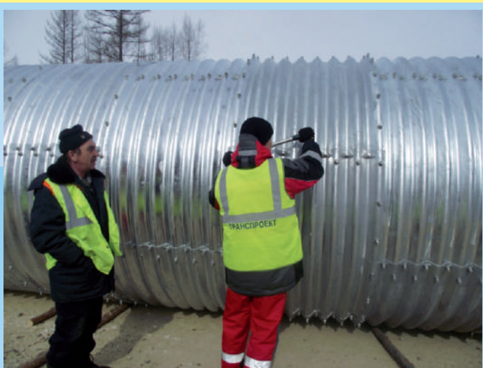
Строительный контроль на автодороге М 56 «Лена» км 93 – км 123
