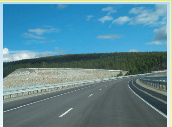
Реконструкция автодороги М 56 « Лена» км 93-км 123
