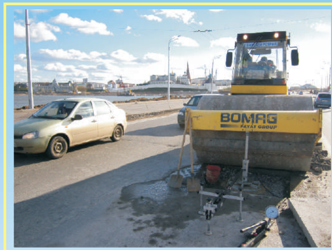
Штамповые испытания на Ленинской дамбе г. Казань
